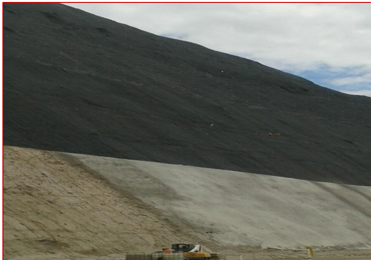
FIGURA 1.35: Uso del No Tejido en la Ingeniería Civil
