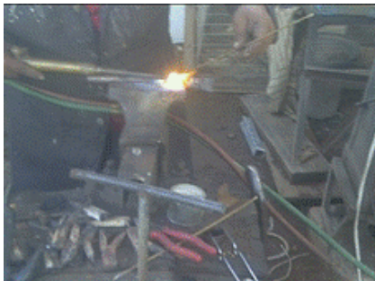
FIGURA 77: Soldadura del sistema de aire
