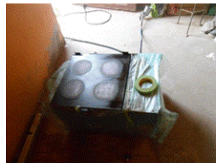
FIGURA 82: Proceso de proceso de pintura
