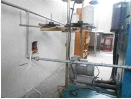
FIGURA 83: Instalación del sistema
