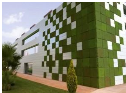
Figura 4 Lifewall: Jardín Vertical de Paneles Modulares que Mejora el Aire Local (FOTOGRAFÍA). 20 DE Mayo del 2010
