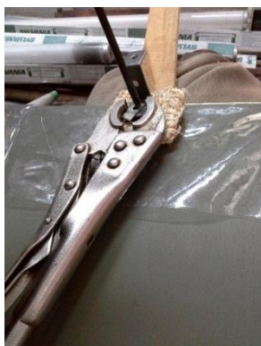
Imagen 140 Colocación de los soportes
