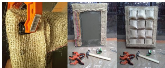
Fig. 15. Inmovilización del sustrato en el panel y colocación de grapas
