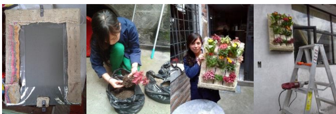
Fig. 16. Colocación de soportes, y plantación del jardín exterior
