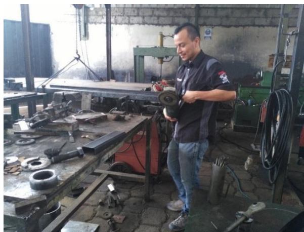
Figura 4. 6 Corte de tubería
