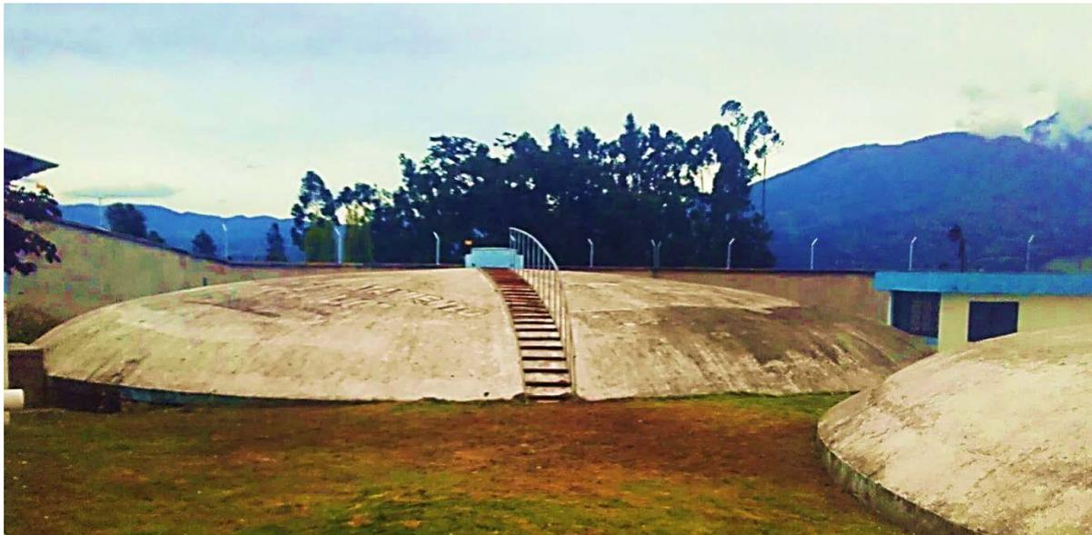
*Figura 12. Tanque #1 de almacenamiento subterráneo de agua potable 1000m<sup>3</sup>.*
