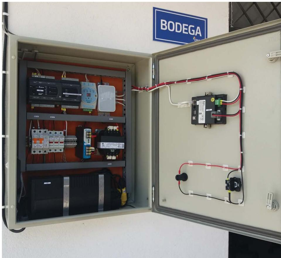
**Figura 35.** Tablero de monitorización de la planta de tratamiento.
