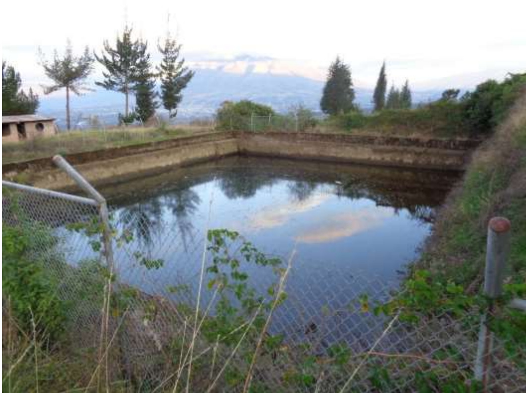
Reservorio comunitario para almacenamiento del agua proveniente de la boca toma
