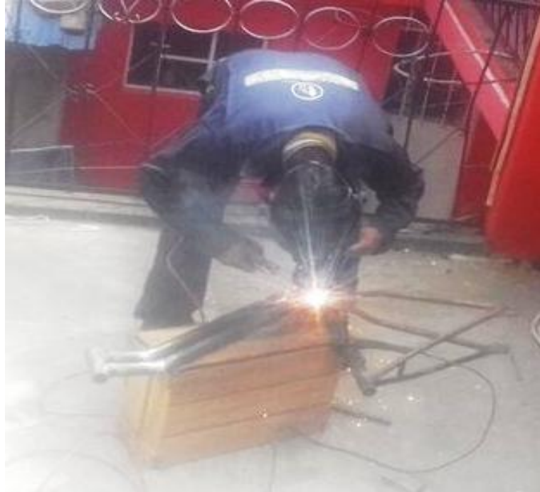
Figura 5.6. Soldadura de los tubos.
