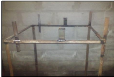
Figura 111: Construcción-bancada mesa de urdir Fuente: Los autores
