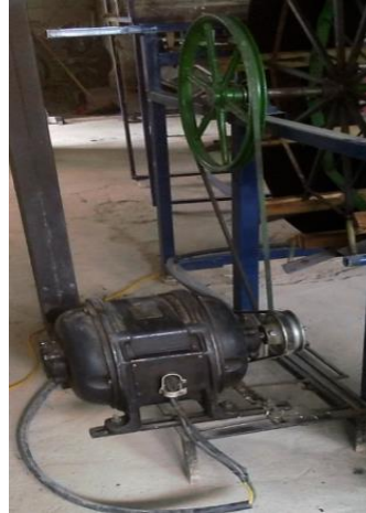
Figura 101. Instalación del motor trifásico. Fuente: Los autores
