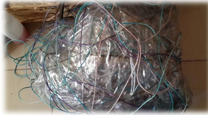
Figura 23. Obra no concluida
