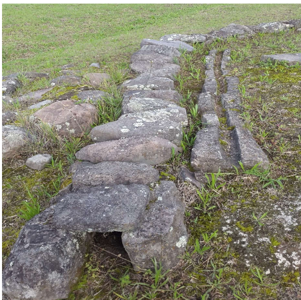
Figura 2. Canal principal de piedra que trasladaba agua a lo largo del lado sur-este de la estructura del Inca Huasi.
