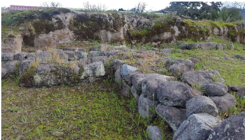
Figura 4. Muros en el Inca Huasi con la técnica de la pirca (paredes levantadas con cantones rodados, asentado con mortero de tierra).
