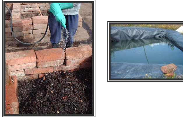
Foto 3.13. Riego de los lechos y reservorio de agua del relleno sanitario
