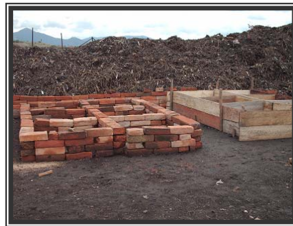
Foto 3.6. Lechos de ladrillo y tabla
