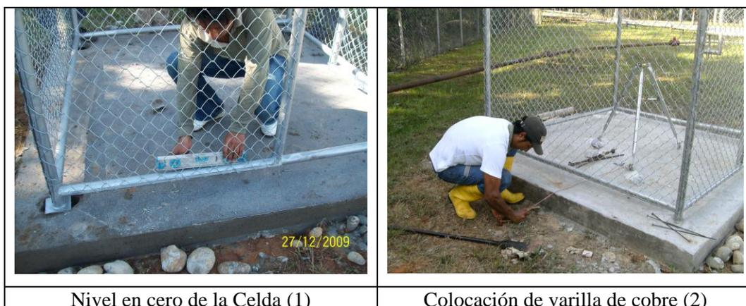
**Fotografía 3.5** Colocación de la Estación Meteorológica en la Celda de Seguridad
