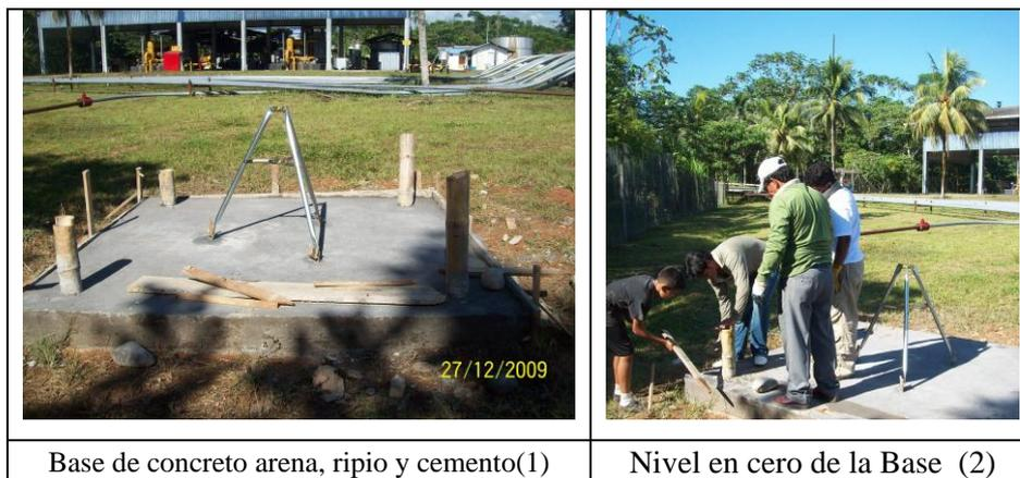
**Fotografía 3.3** Construcción de la Base de la Estación Meteorológica
