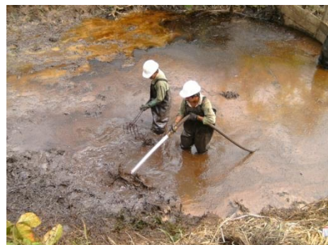
Foto 81: Lavado de sedimentos y material contaminado
