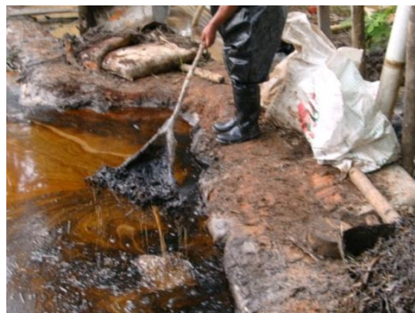
Foto 87: Recuperación de petróleo y material contaminado
