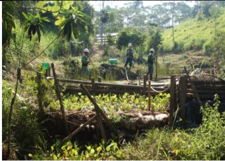
Foto 96: Mejoramiento sustrato del pantano (adición de abono)
