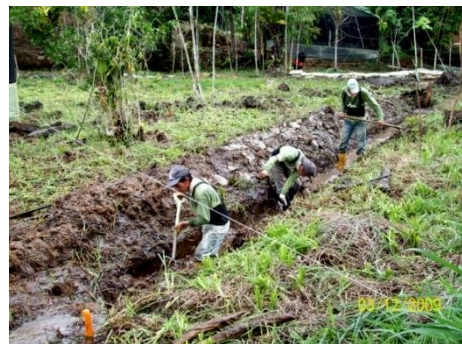
Foto 67: Construcción zanjas (Drenaje)
