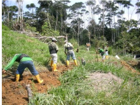
Foto 64: Construcción de cunetas
