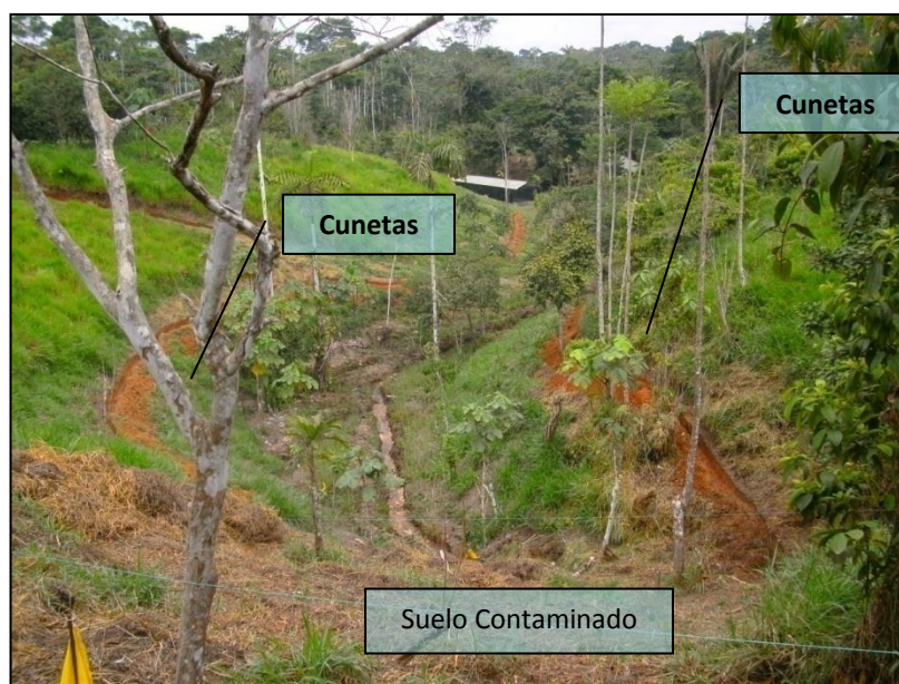
Fotografía 4: Delimitación Física (cunetas)
