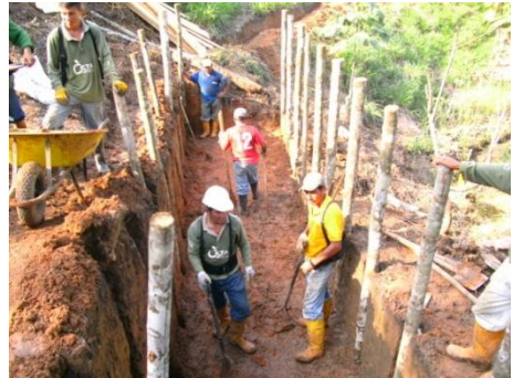
Foto 9: Colocación de postes
