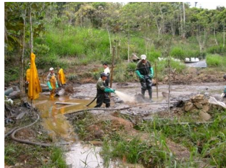
Foto 79: Lavado de sedimentos y material contaminado
