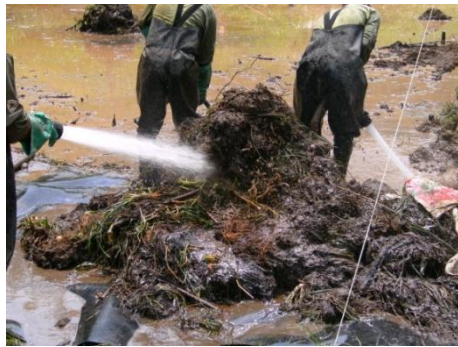
Foto 84: Lavado material contaminado
