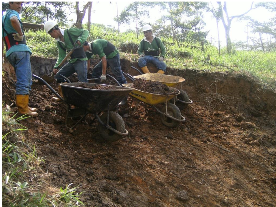
Foto 15: Extracción del lugar del derrame
