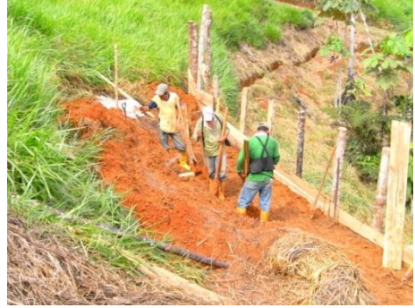
Foto 7: Conformación de la terraza
