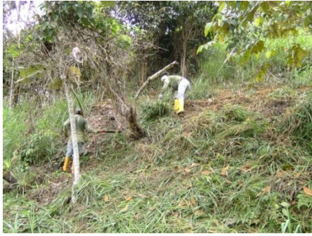
Foto 6: Limpieza del área
