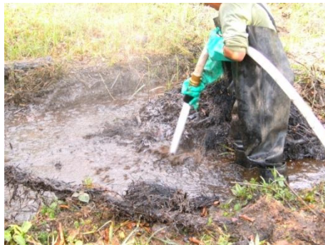
Foto 78: Lavado de sedimentos y material contaminado
