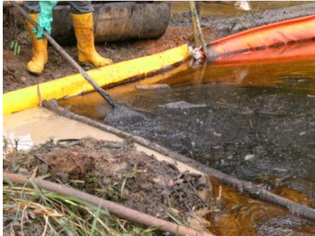
Foto 88: Recuperación de petróleo y material contaminado
