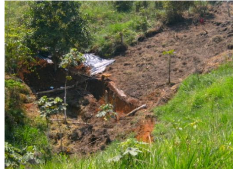
Foto 2: Aérea de suelo contaminado
