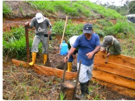
Foto 70 - 71: Construcción de sedimentadores con postes y tablas
