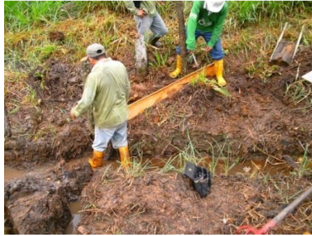
Foto 70 - 71: Construcción de sedimentadores con postes y tablas
