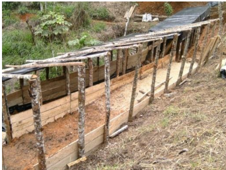
Foto 8: Conformación de la terraza
