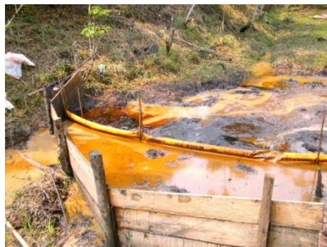
Foto 93: Medidas de protección (sedimentador y barreras)
