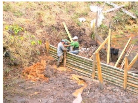
Foto 73: Sediementador con bamboo y postes
