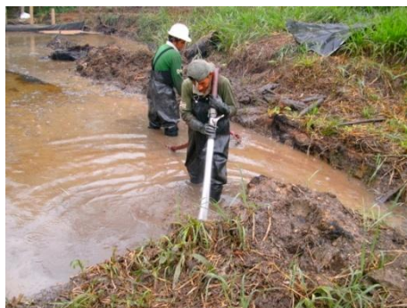
Foto 80: Lavado de sedimentos y material contaminado
