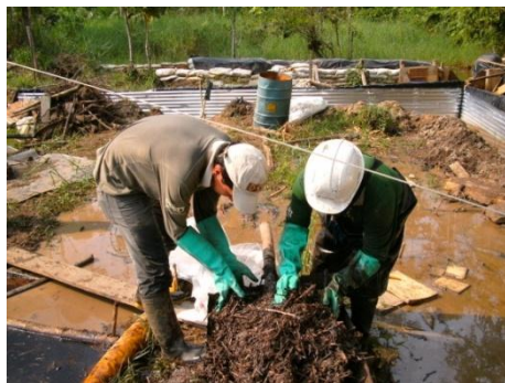
Foto 86: Recuperación de petróleo y material contaminado
