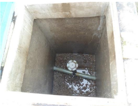
Fotografía 13. Válvula de aire en conducción
