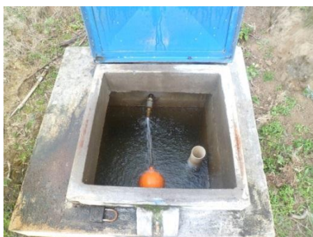
Fotografía 23. Tanque reductor de presión (TRP)
