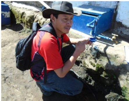
Fotografía 33. Detección de fugas en el sistema
