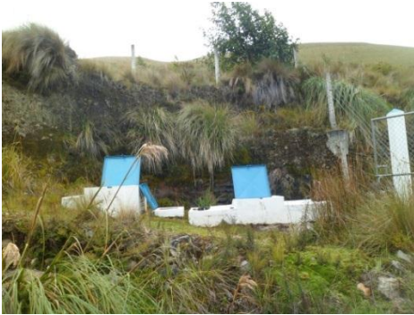
Fotografía 11. Desarenador y sedimentador
