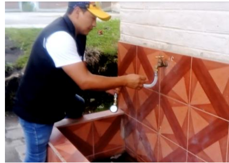
Fotografía 42. Medición de presión en usuarios
