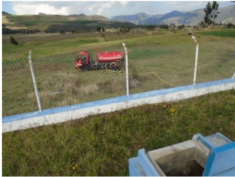
Fotografía 31. Compensación de suministro en tanques de reserva, época seca
