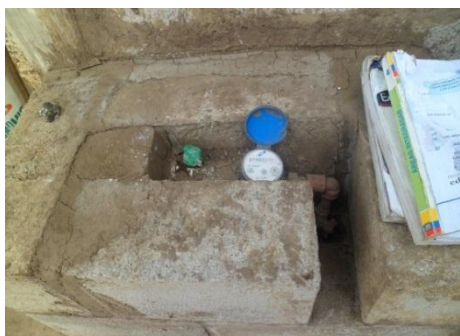
Fotografía 27. Protección de micro medidores
