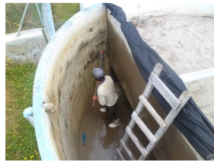
Fotografía 16. Mantenimiento de Filtro dinámico ascendente
