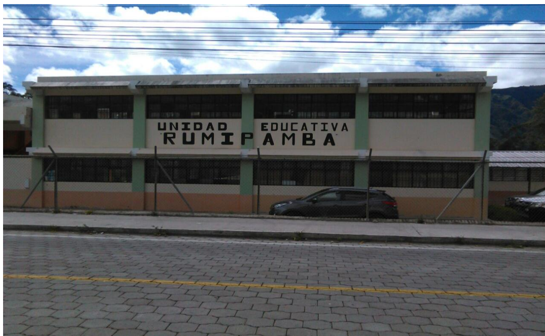
Fachada de la Unidad Educativa Rumipamba
