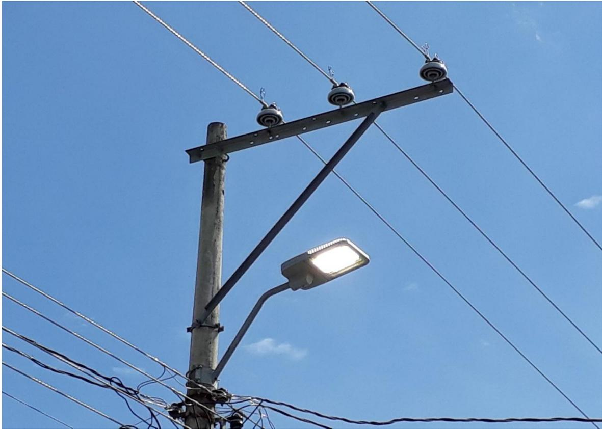
**Figura N° 21** Lámpara Led de 110w sector Atuntaqui
