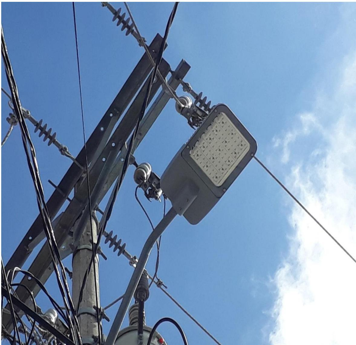
**Figura N° 20** Lámpara Led de 110w sector Atuntaqui
