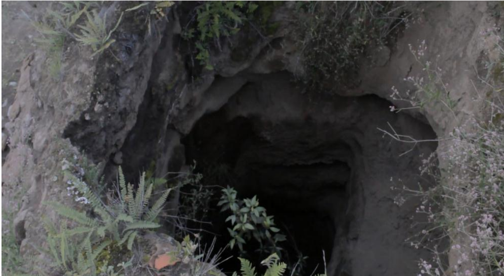
Figura 11. Ingreso superior paso de agua
