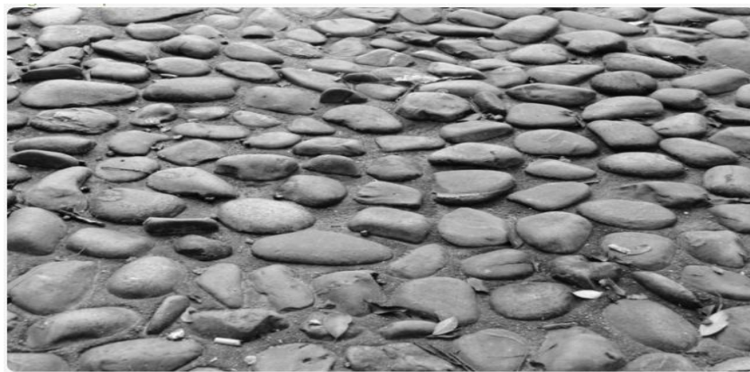
Figura 13. Encajado de roca
