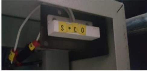
Figura 62. Sensor magnético instalado en la parte superior de la compuerta del tablero
