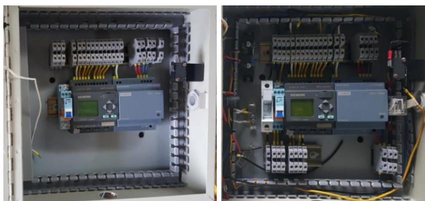
Figura 54. Proceso de montaje de tablero de control
