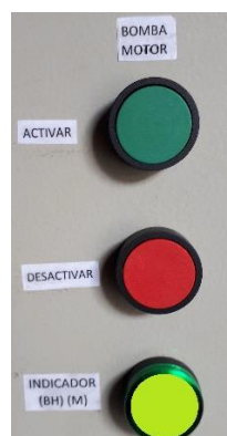
Figura 42: Señal luminosa de activación de bomba hidráulica y motor
