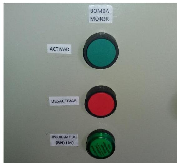
*Figura 28: Representación de los botones para el encendido y apagado de la Bomba y el motor (TABLERO)*
