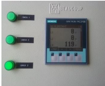
Figura 27. Lectura de variables eléctricas con corte energético
