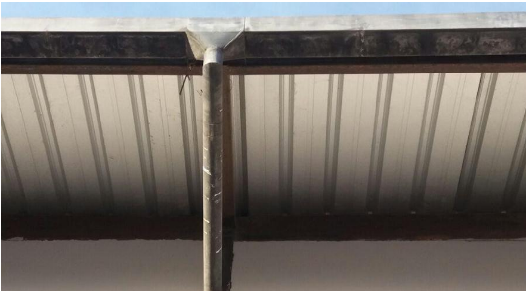
Figura III.2. Cubierta del taller con instalación de canaletas de agua
