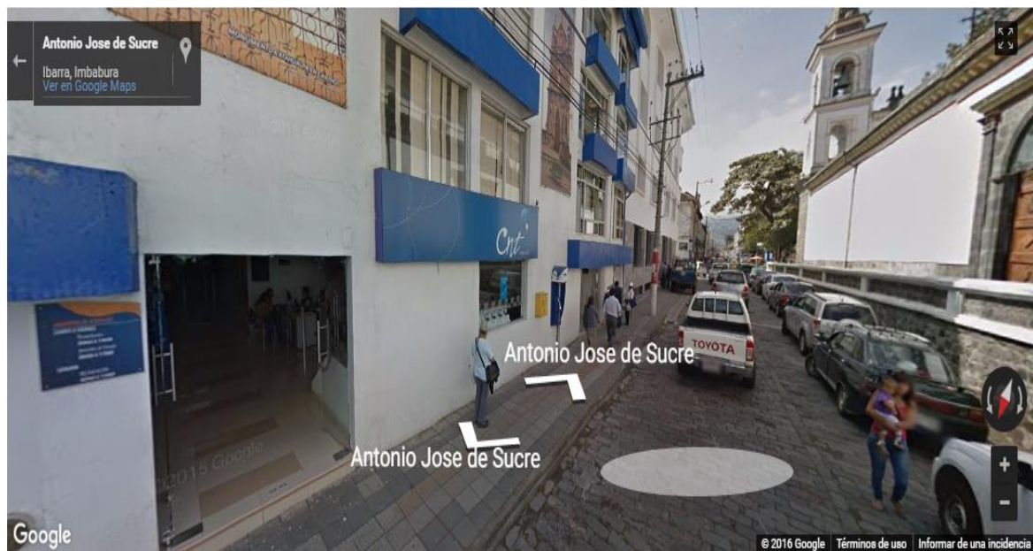
Figura 3. Ubicación exacta y vista del ingreso de la empresa. Copyright 2016 Google Street View
