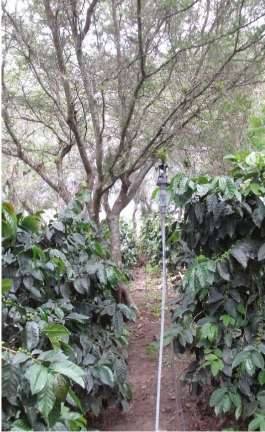
Foto 9. Sistema de riego por aspersores
