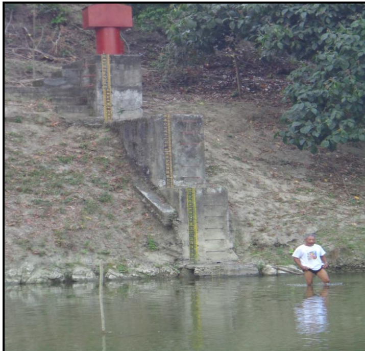
Figura 42. Estación H0173 Teaone DJ Esmeraldas
