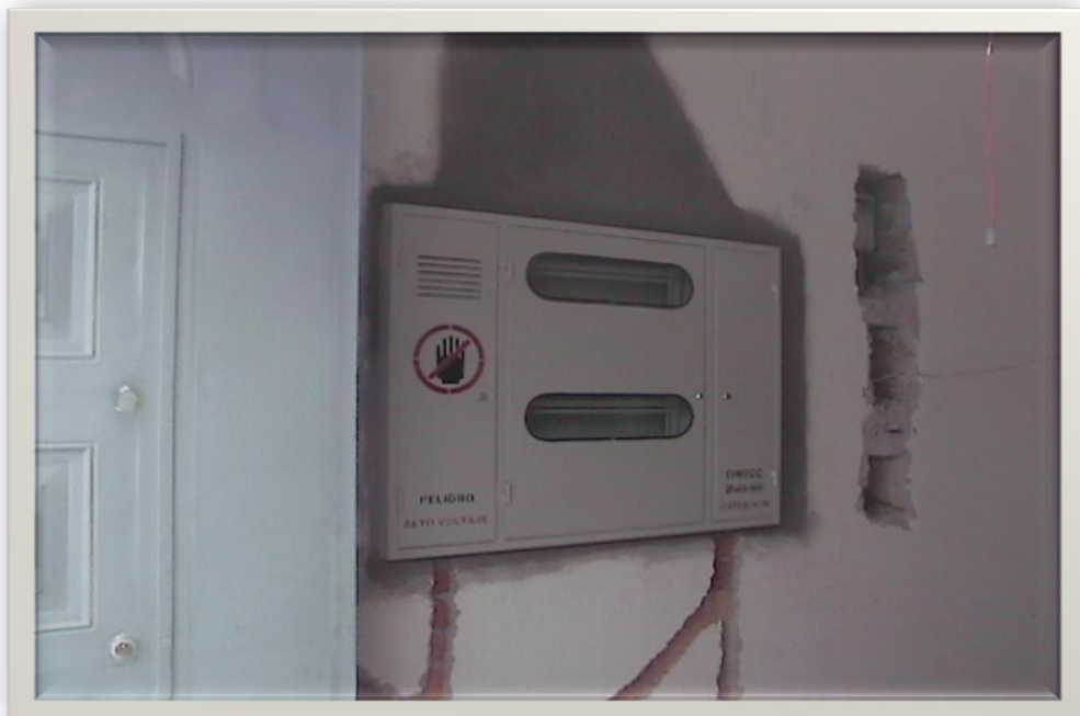
Instalación de un tablero en una vivienda
