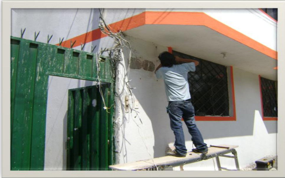
Proceso de instalación de tablero
