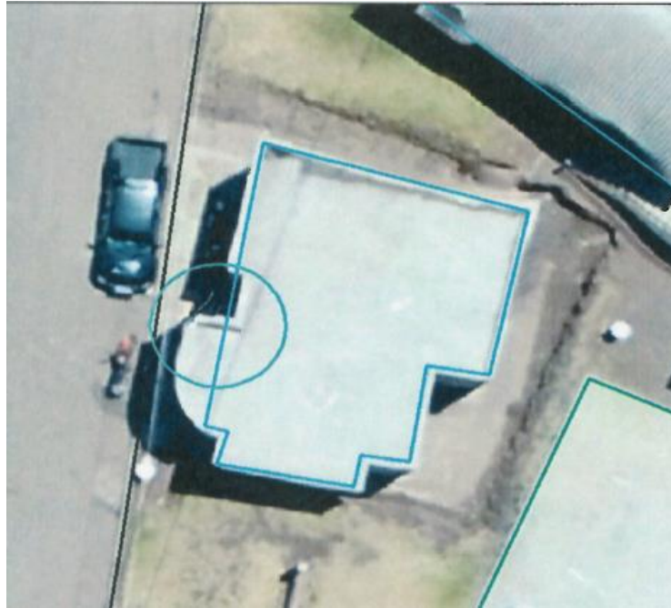
Figura 15. Mal trazo de edificio Elaborado por: Jefferson Carrera, Fotografías obtenidas con el Drone
