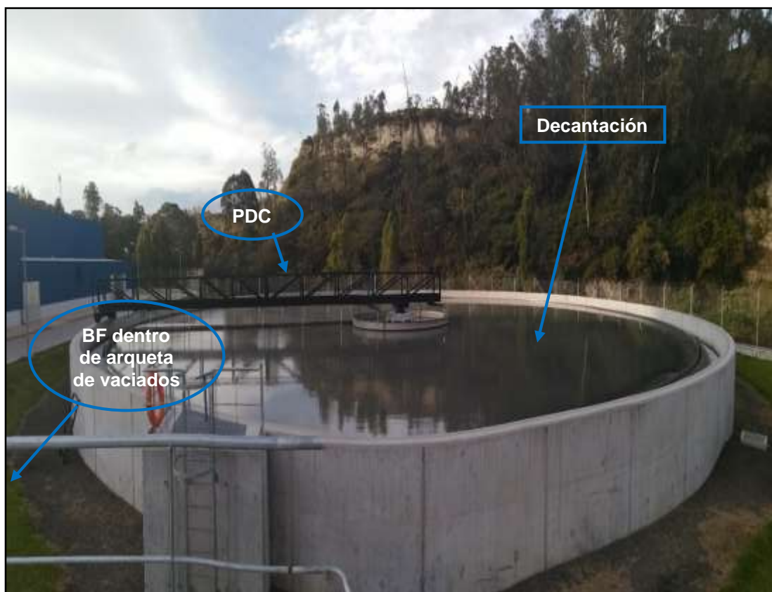
Fig. 9. Sección decantación, línea de agua PTAR-I (Autor).
