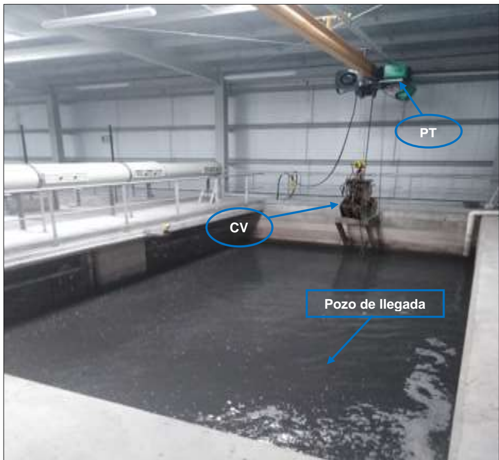
Fig. 6. Pozo de llegada, línea de agua PTAR-I (Autor).
