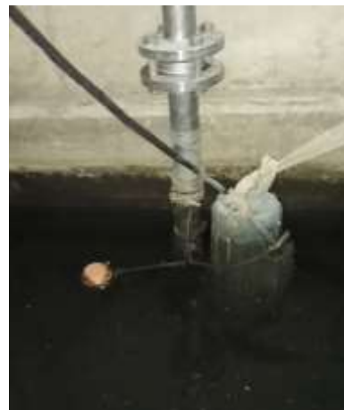
Fig. 34. Bomba Flotante, existen 2 en esta sección (Autor).
