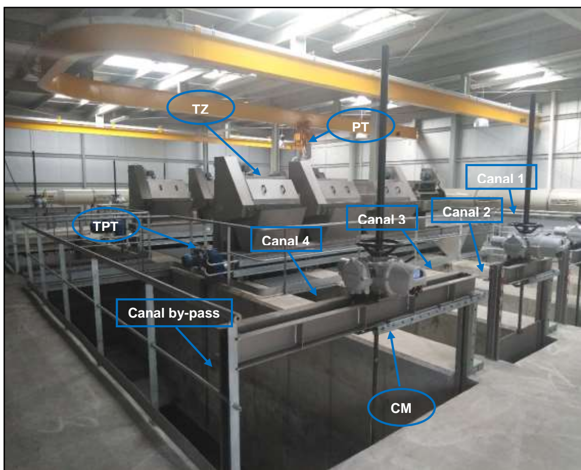
Fig. 7. Sección desbaste, línea de agua PTAR-I (Autor).
