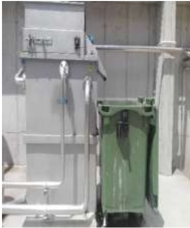
Fig. 30. Concentrador de grasas y flotantes (Autor).
