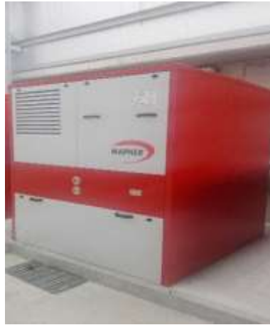
Fig. 31. Soplante con cabina insonorizante, existen 3 en esta sección (Autor).
