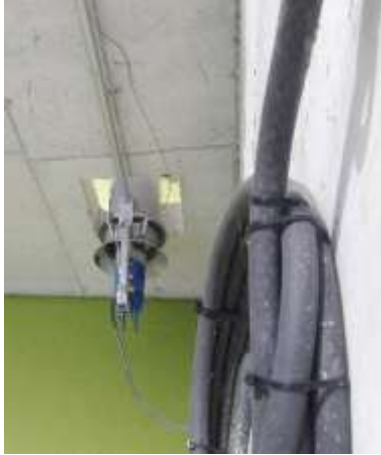
Fig. 38. Bomba de recirculación sumergible, existen 2 en esta sección (Autor).
