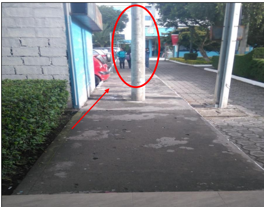
Figura 33. Poste obstaculizando el camino entre el Edificio Central y la FECYT.
