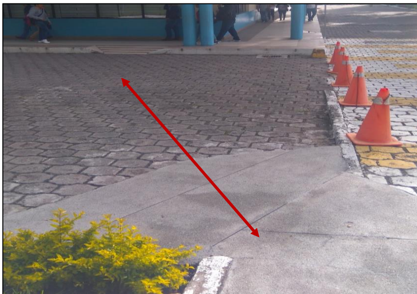
Figura 31. Desalineación de puntos de acceso para personas con discapacidad que provoca giros innecesarios
