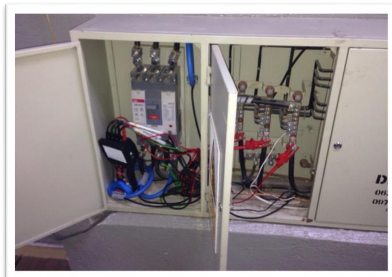
Ilustración 9; Conexión del equipo de medición.
