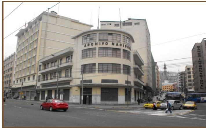
Instalaciones del Archivo Nacional en Quito
