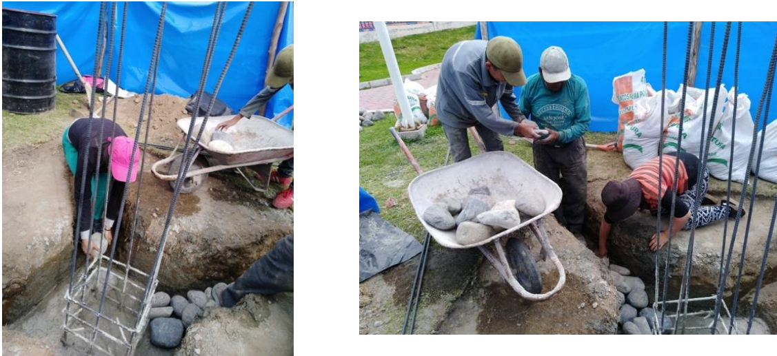
Figura 56. Colocación de piedras en la perpendicular.
