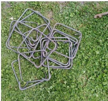
Figura 55. Creación de estribos y fundición de columna.
