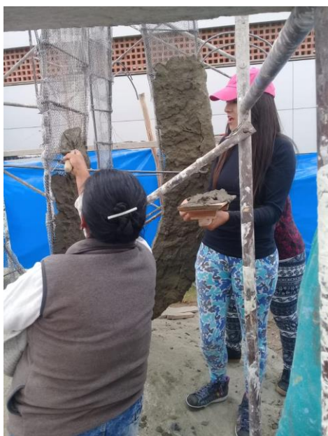
Figura 62. Colocación de la mezcla en la malla
