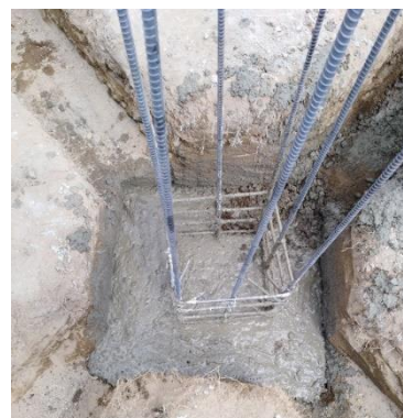
Figura 55. Creación de estribos y fundición de columna.
