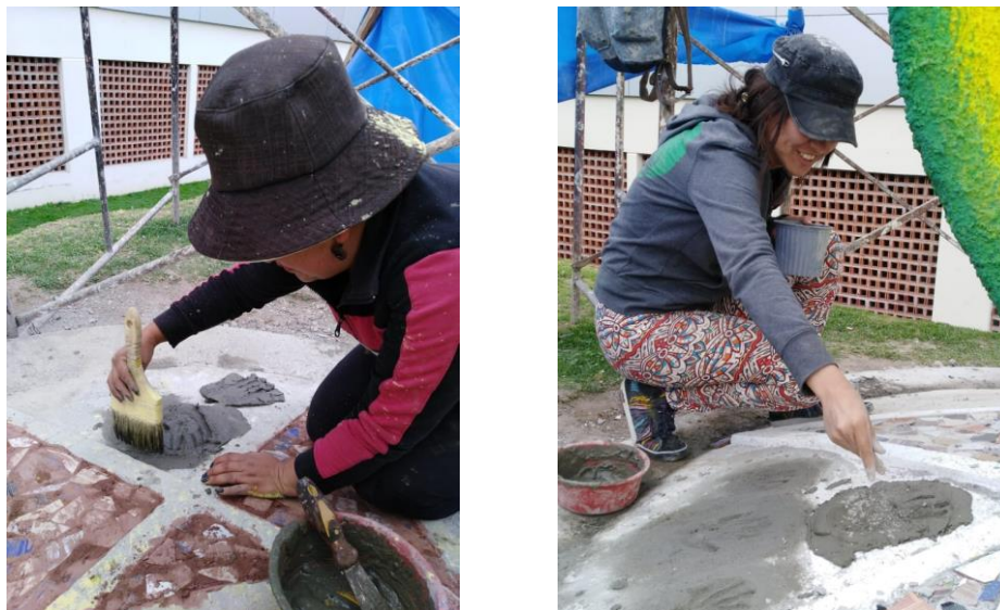
Figura 72. Acabados de la huella
