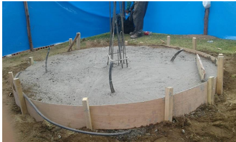
Figura 58. Fundición y fraguado de la base.
