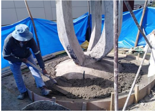
Figura 64. Enlucido de la base.
