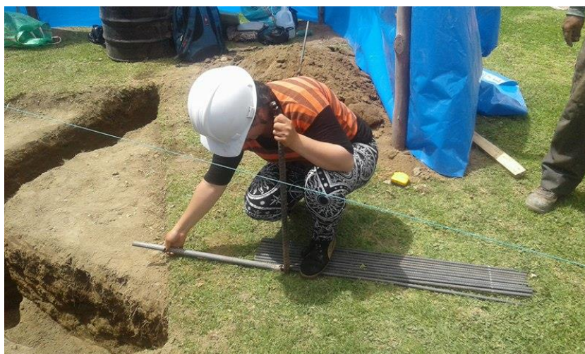
Figura 59. Proceso de dobles, amarrado y fundido de la estructura de la luna.
