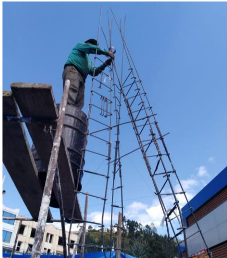
Figura 61. Colocación de estribos y malla
