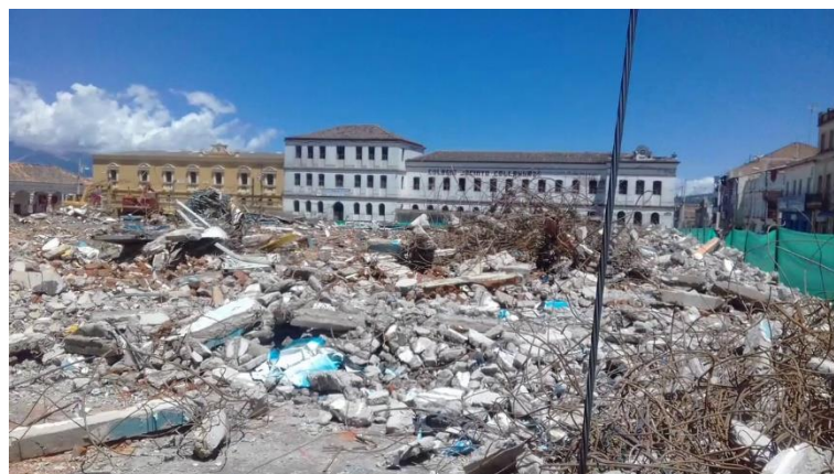
Figura 25. Demolición del Mercado.
