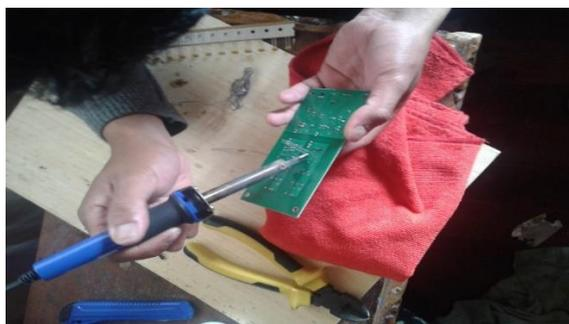
Figura 71. Montaje de elementos en placa de accionamientos de IGBT
