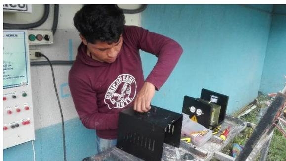
Figura 70. Readequación de conexión en transformadores monofásicos
