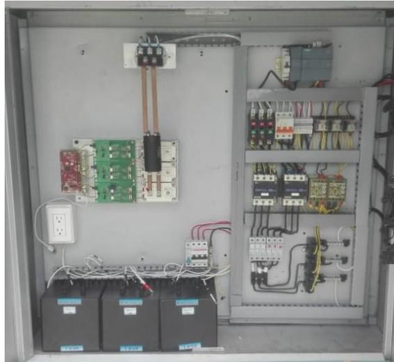
**Figura 51. Instalación de módulo inversor trifásico en tablero eléctrico**
