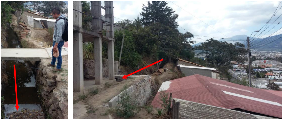
Foto 4. Canal de riego (Flanco izquierdo del área de estudio Barrio la Quinta del Olivo)
