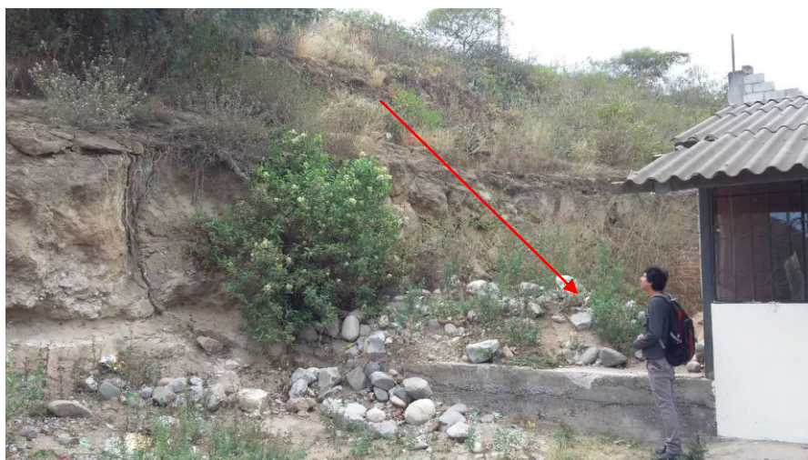
Foto 2.3. Casa comunal afectada parcialmente por deslizamiento (La Quinta del Olivo)
