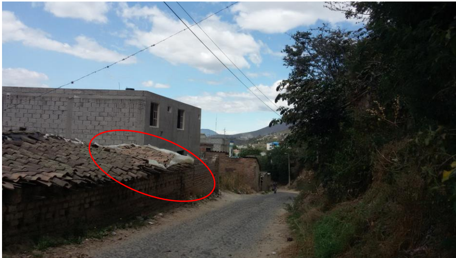
Foto 2.1. Vivienda afectada por deslizamiento (Vía al Arcángel)
