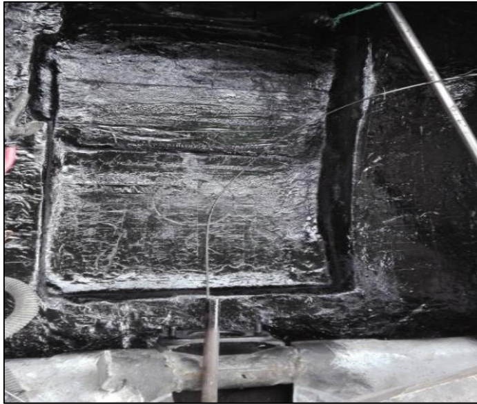
Figura 3.4 Preparación de área base para ubicar el motor y caja de cambios
