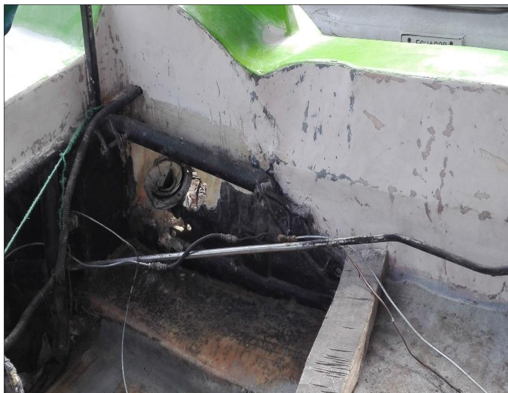
FIGURA AII.4. Desmontaje de ejes de transmisión
