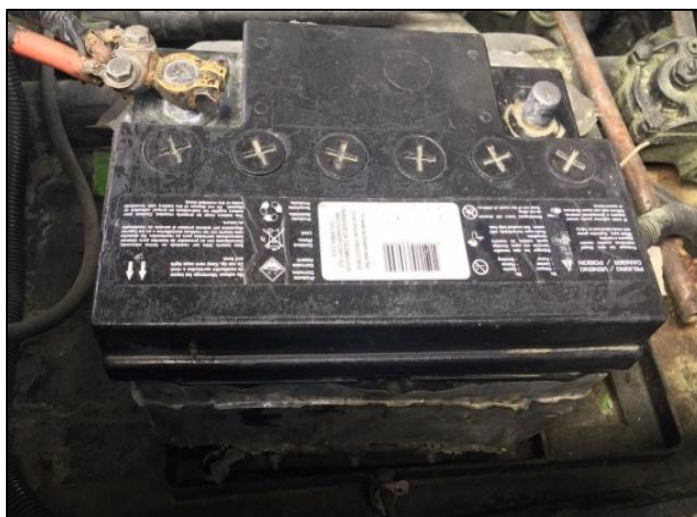
Figura 3.11 Instalación de nueva batería en vehículo tipo anfibio
