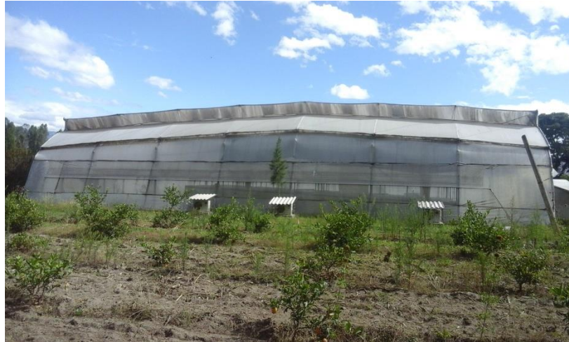
Figura 3. Vista lateral del invernadero
