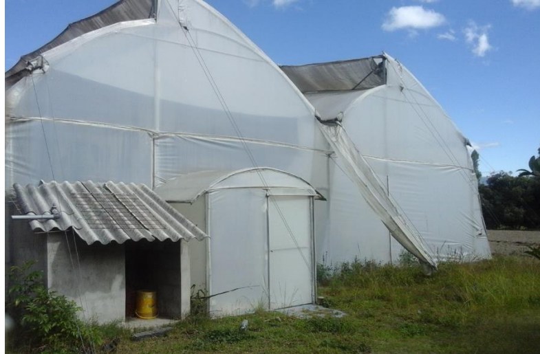
Figura 5. Vista frontal del invernadero
