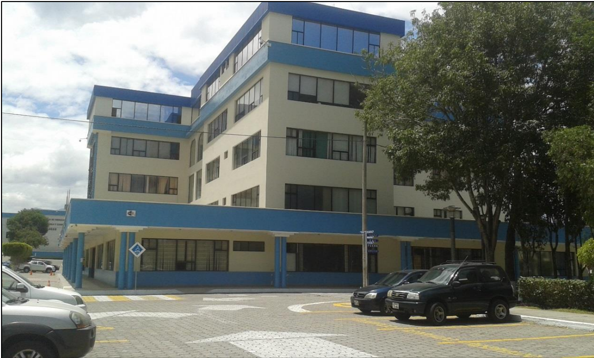
Ilustración 7. Fachada Izquierda del Edificio Central Administrativo de la UTN Fuente: El Autor (2019)
