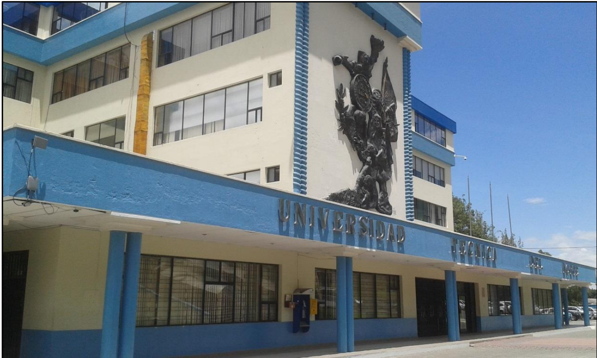
Ilustración 5. Fachada Delantera del Edificio Central Administrativo de la UTN
