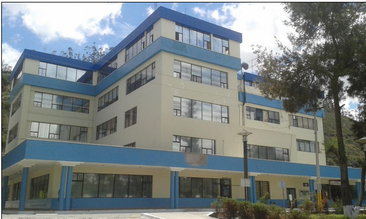
Ilustración 6. Fachada Posterior del Edificio Central Administrativo de la UTN
