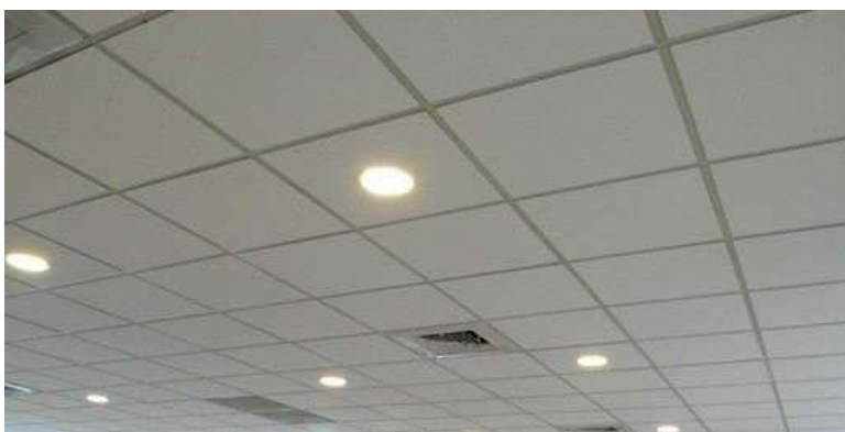
Figura 77. Techo en material Gypsum para la planta
