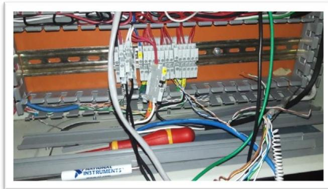
**Figura 42** Reajuste de cables internos
