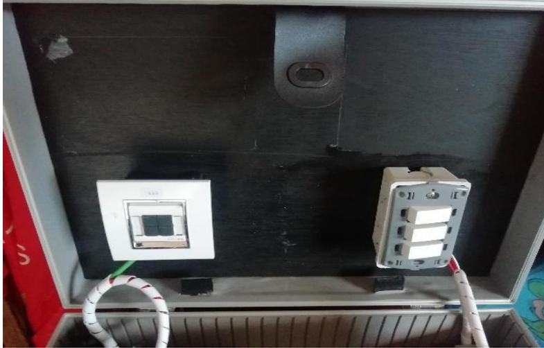
**Figura 44:** Perforación tablero y montaje de dispositivos
