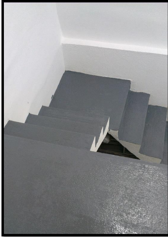
Figura D- 10. Ingreso al centro de datos piso con pintura electrostática Fuente: Centro de datos RECAPT, (2016).
