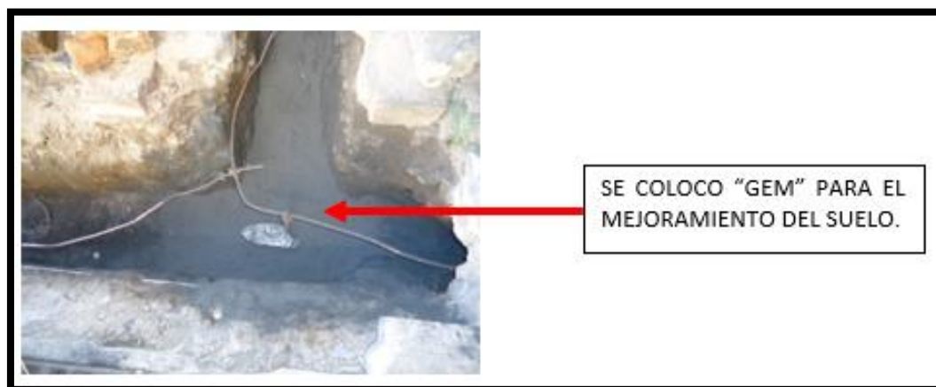
Figura D- 27. Mejoramiento de suelo con GEM Fuente: Centro de datos RECAPT, (2016).
