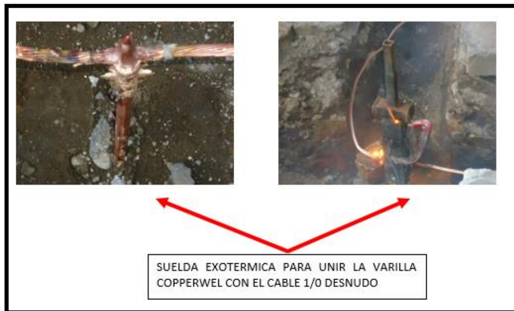
Figura D- 26. Suelda exotérmica Fuente: Centro de datos RECAPT, (2016).
