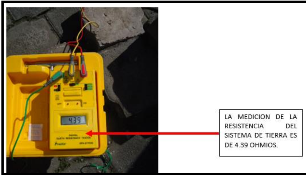
Figura D- 28. Medición de la resistencia del sistema de tierra Fuente: Centro de datos RECAPT, (2016).
