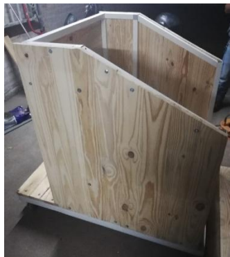
Figura 31: Colocación de la madera en la estructura de aluminio Fuente: Autor
