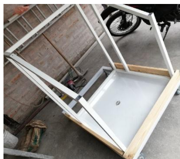
Figura 29: Construcción y fijación de la estructura de aluminio al pie de ducha Fuente: Autor
