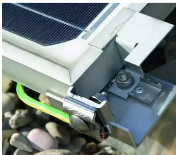
Figura 41. Puesta a Tierra Estructura de Soporte de Paneles 14 AWG. Fuente: Bluesun Solar, (2016).
