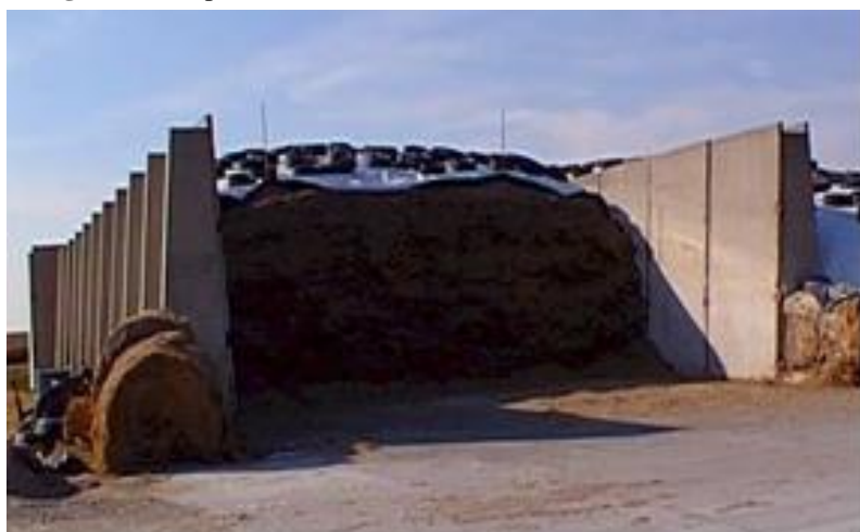
Imagen 5 Silo tipo Bunker
