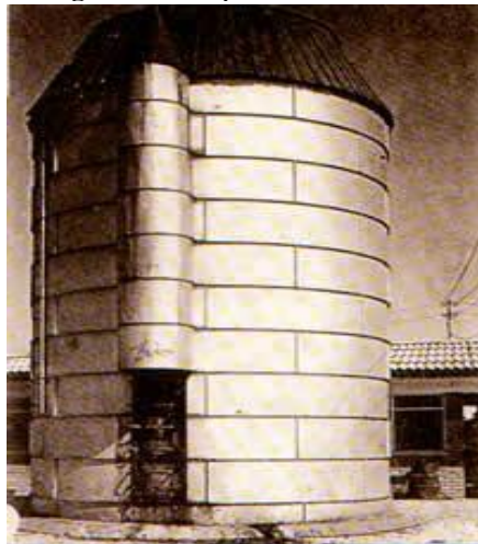
Imagen 2 Silo tipo torre
