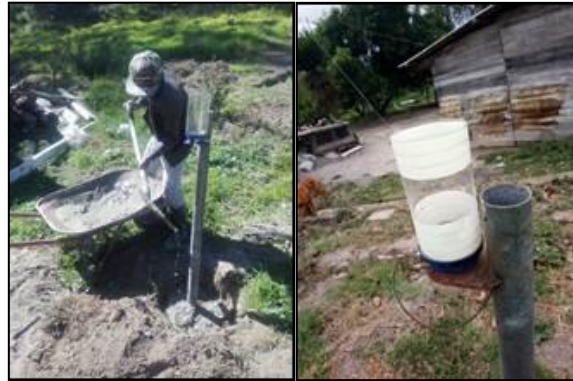
Figura 33. Instalación pluviómetro.
