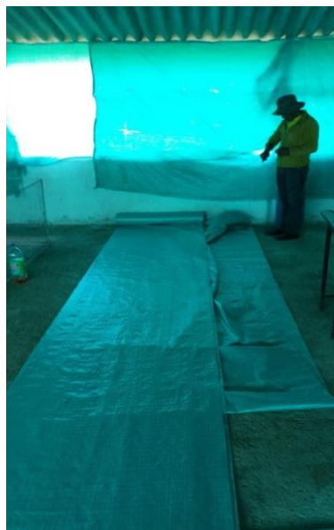
Figura 10: Colocado de cortinas en la parte externa e interna del galpón
