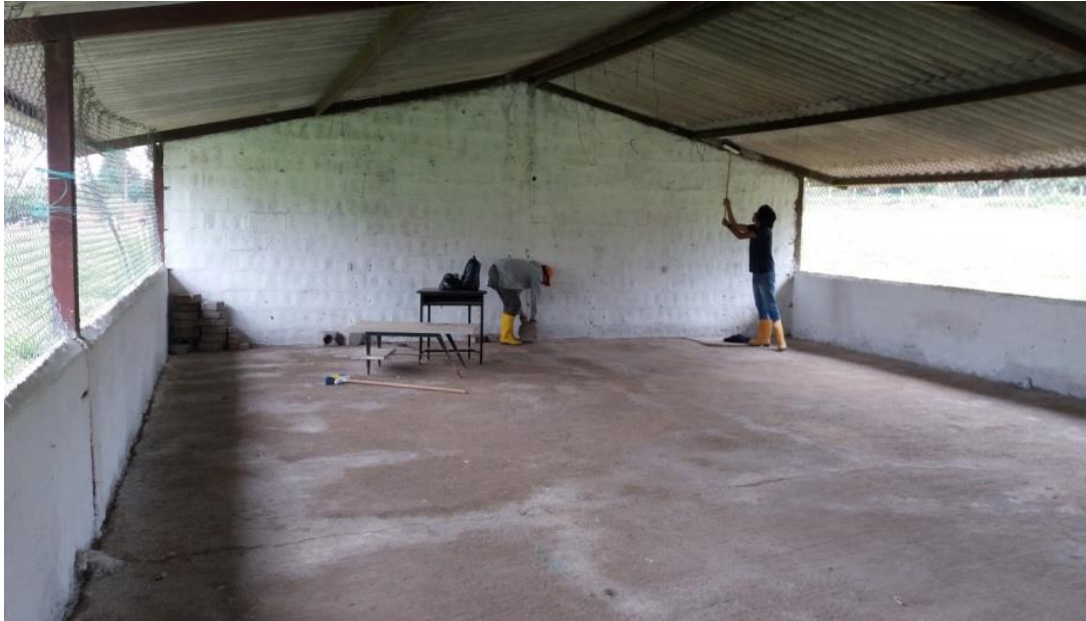
Figura 9 : Limpieza del galpón
