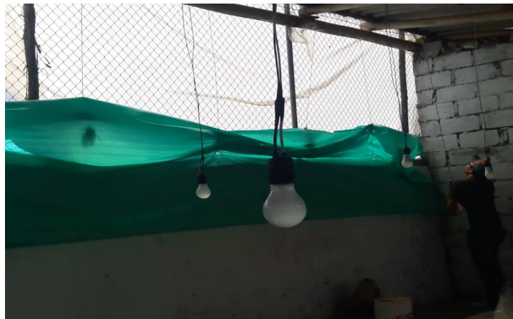
Figura 8. Colocación de cortinas.
