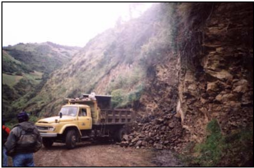
Foto N° 45 Maquinaria de Movilización de Material
