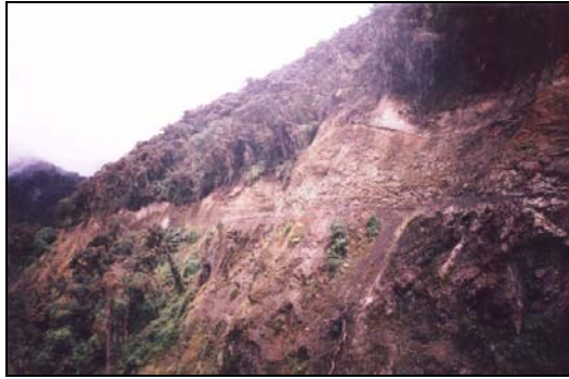
Foto N° 18 Taludes Desprovistos de Cobertura Vegetal e Inestables
