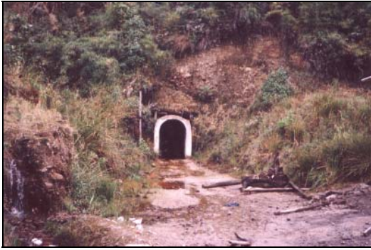
Foto N° 33 Túnel Longitud 1 Km. para Conducción del Canal
