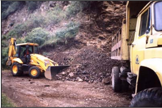
Foto N° 46 Maquinaria de Remoción y Movilización de Material
