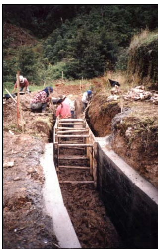
Fotos N° 12, 13 y 14 Construcción del Canal, Fases de Fundido y Desencofrado.
