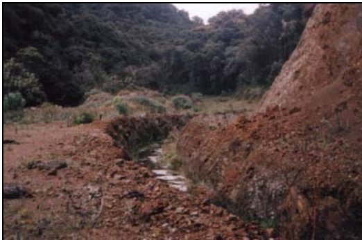
Foto N° 4 Excavación del Canal y Balconeo del Material Removido
