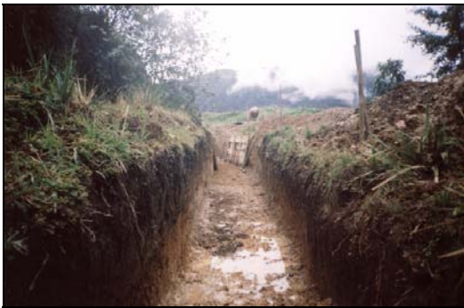
Foto N° 5 Limpieza del Canal para Medir y Encofrar
