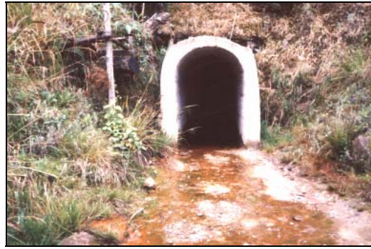
Foto N° 34 Túnel para Disminuir la Longitud del Canal
