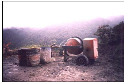
Foto N° 48 Maquinaria e Insumos para la Construcción del Canal
