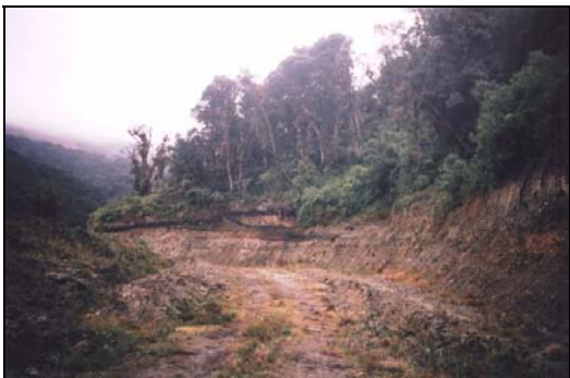
Foto N° 3 Desbroce y Desbanque de la Línea de Conducción
