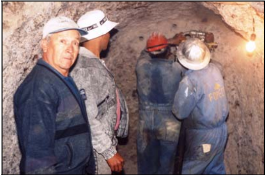
Foto N° 43 Personal Técnico de Perforación del Túnel
