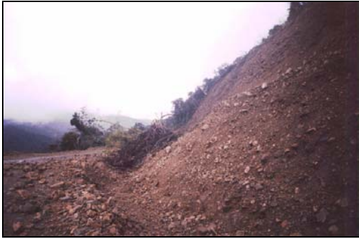
Foto N° 17 Taludes Inestables (Material Suelto)
