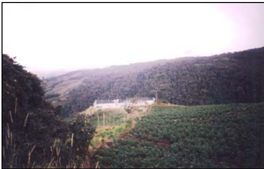
Foto N° 31 Tanque Reservoirio de Agua Parte Media del Proyecto
