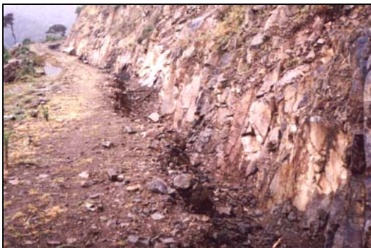
Foto N° 29 Excavación del Canal en Afloramiento Rocoso
