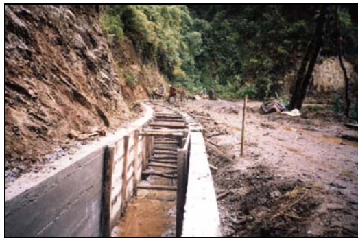
Foto N° 6 Construcción del Canal, Fraguado y Desencofrado
