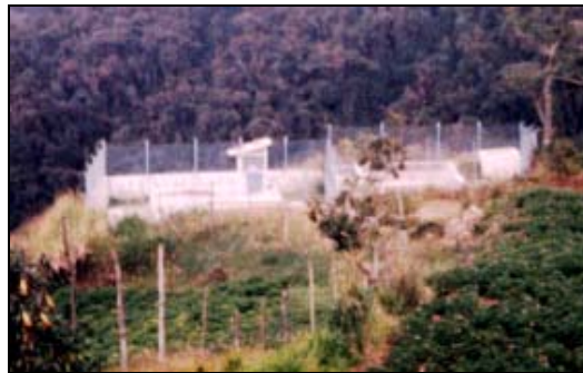
Foto N° 32 Cerramiento del Tanque Reservoirio de Agua
