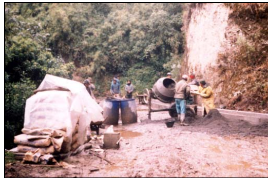
Foto N° 44 Personal de Construcción del Canal
