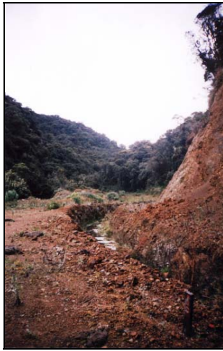
Fotos N° 9, 10 y 11 Construcción del Canal, Fases de Excavación, Medición y Encofrado.
