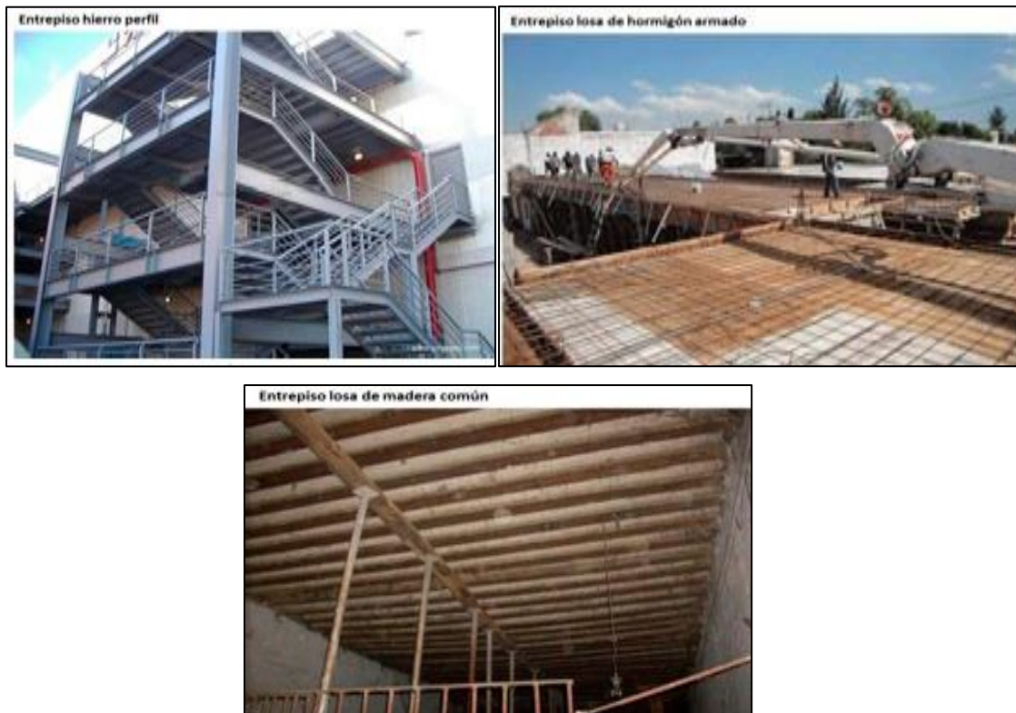
Figura 68. Entrepisos de Hormigón, Hierro y Madera
