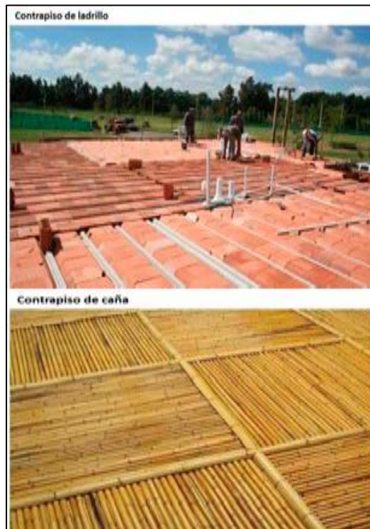
Figura 67. Contrapisos de Tierra, Caña y Ladrillo
