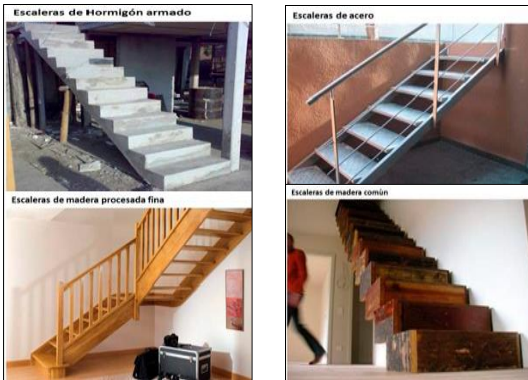
Figura 71. Tipos de Escaleras
