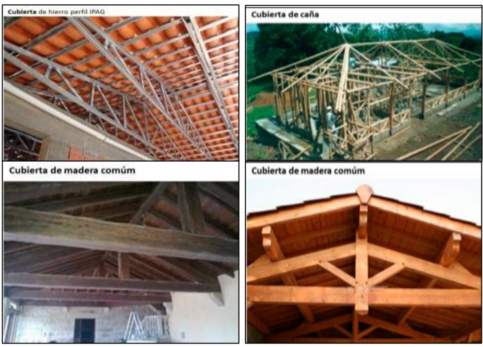
Figura 70. Cubiertas de Madera, Caña y Hierro
